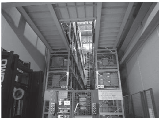
写真 1 自動倉庫（作道印刷）
